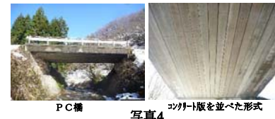
写真4 小規模橋梁の外観と特徴を示す写真。
