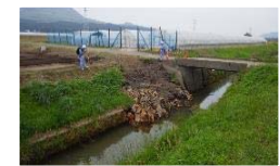
写真6 橋梁の点検結果を示す写真。
