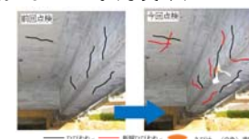
写真5 橋梁の点検結果を示す写真。
