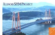
対象とする橋梁
